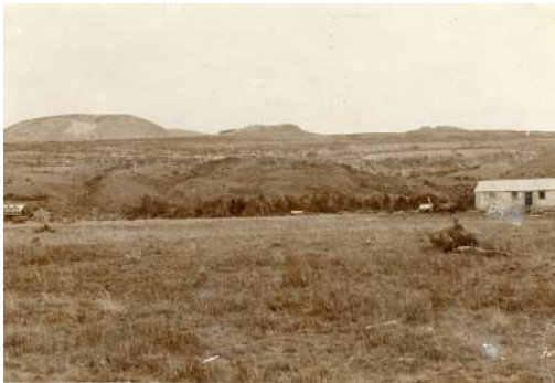
EMPLAZAMIENTO DE LA ANTIGUA CASA DE ADMINISTRACIÓN Y PUESTO DE TRABAJADORES DEL LOTE DE ÑIREHUAO DE LA SOCIEDAD INDUSTRIAL DEL AISÉN (S.I.A.), ÑIREHUAO, COMUNA DE COYHAIQUE, REGIÓN DE AYSÉN, C. 1913. COLECCIÓN ARCHIVO FOTOGRÁFICO DEL MUSEO REGIONAL DE AYSÉN (MURAY). NÚMERO INVENTARIO FB000549.
