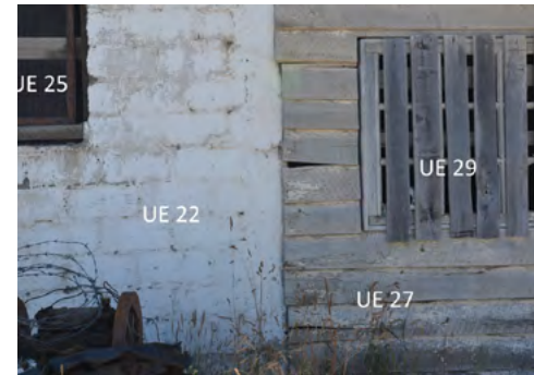
DETALLE UE 22, 25, 27 Y 29. CORRESPONDE A DOS ESTRUCTURAS ADOSADAS: UNA REALIZADA EN ALBAÑILERÍA DE LADRILLO DE CEMENTO Y LA OTRA ESTRUCTURA DE MADERA. SE DISTINGUEN ADEMÁS EN CADA UNA DE ESTAS ESTRUCTURAS SUS RESPECTIVAS VENTANAS. FOTOGRAFÍA: JAVIERA LETELIER COSMELLI.
